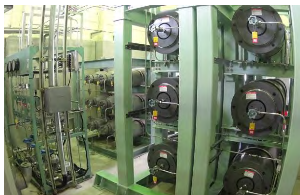
図 1 圧縮水素試験設備の蓄圧容器
