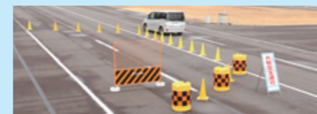
多目的市街地における道路工事状況の再現例 Example of artificial road construction situation in versatile urban area
