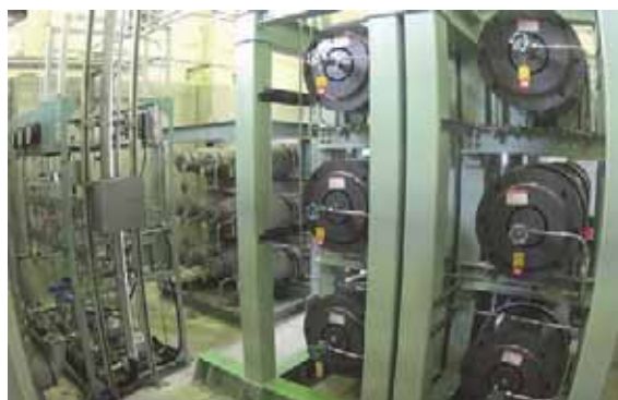
図 5.23 圧縮水素試験設備の蓄圧容器
