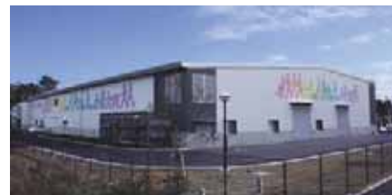
図 5.40 11月より本格稼働を開始したロボット安全試験センター
