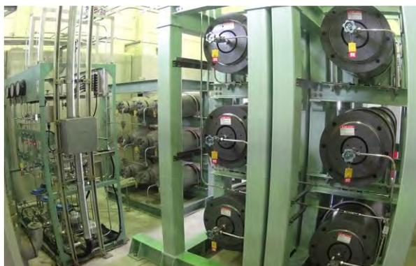
図23 圧縮水素試験設備の蓄圧容器
