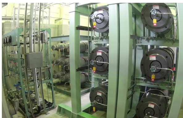
図23 圧縮水素試験設備の蓄圧容器
