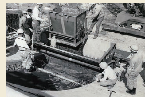
木の型枠にコンクリートを流し込む作業
